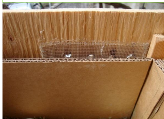
Slika 4: Izolirana stena z zračniki.
