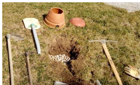
Slika 4.5: Pripravljena je jama z gramozom za drenažo.
